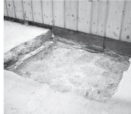
Alles Rätselraten half nicht weiter, es musste eine Wand geöffnet werden. Zu dem Zweck stemmte man den Bereich zwischen Toilette und Dusche komplett auf. Zu Tage kam das schadhafte Rohr und im Hohlraum zwischen den Wänden ein wunderbarer Platz zur Entsorgung von damaligem Bauschutt: Alte Dichtungen, Steinbruch, Metall und sonstiger Unrat wurden hier ganz nebenbei aufgetan.
