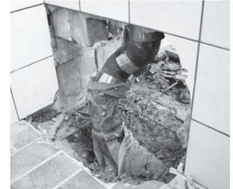
ist schier unmöglich. Da die Kamerafahrt an drei von vier Fallrohren ein ähnliches Schadensbild offenbart hat, wird die Maßnahme nun doch etwas umfangreicher. Ab Mitte Dezember regiert der Bosch-Hammer. Sanitiert werden die vertikalen Teile und die Übergänge durch Neuverlegung und die Grundleitungen mittels Inliner (das ist ein harzgetränkter Schlauch, der von innen an die Rohrwand eingeklebt wird).
